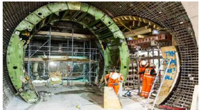
Рис. 13. Станция Виктория ведется работы по обновлению ([16] и https://www.youtube.com/смотреть?v=P60EрYtwM7Y )
